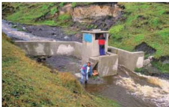
*Estación limnimétrica « Humboldt » construida en 1999 por el IRD y la Empresa Municipal del Agua de Quito (EMAAP-Q) para el monitoreo hidrológica de la cuenca del glaciar 12 Los Crespos del Antisana. Foto B.Francou*
